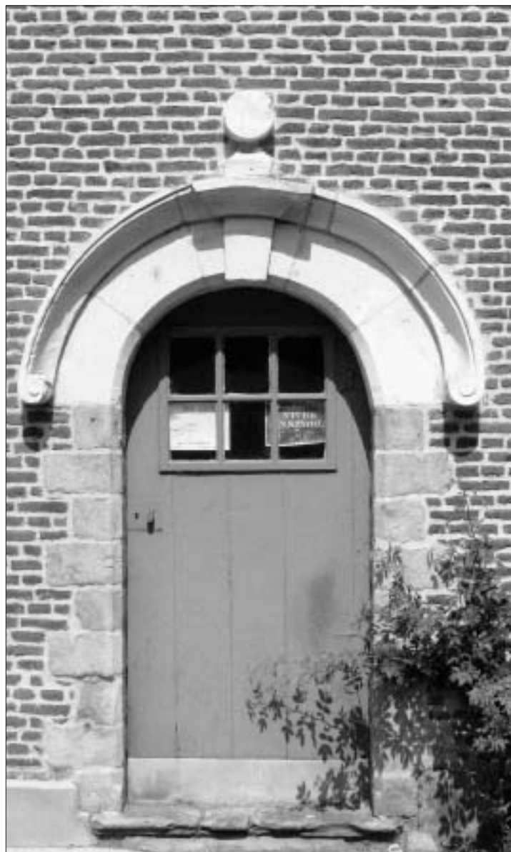
La porte du local où était placé le four à pain. Un élément indispensable de la nourriture du malade.
